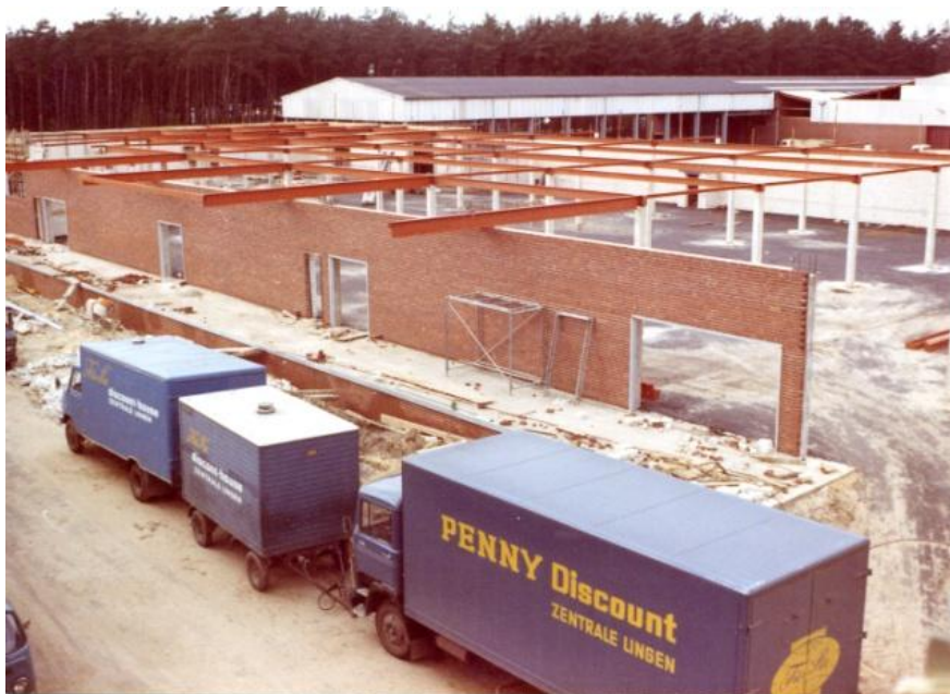
Lieferfahrzeuge der Firma Berndt & Co. vor dem Rohbauder zweiten Lagerhalle im April 1972
