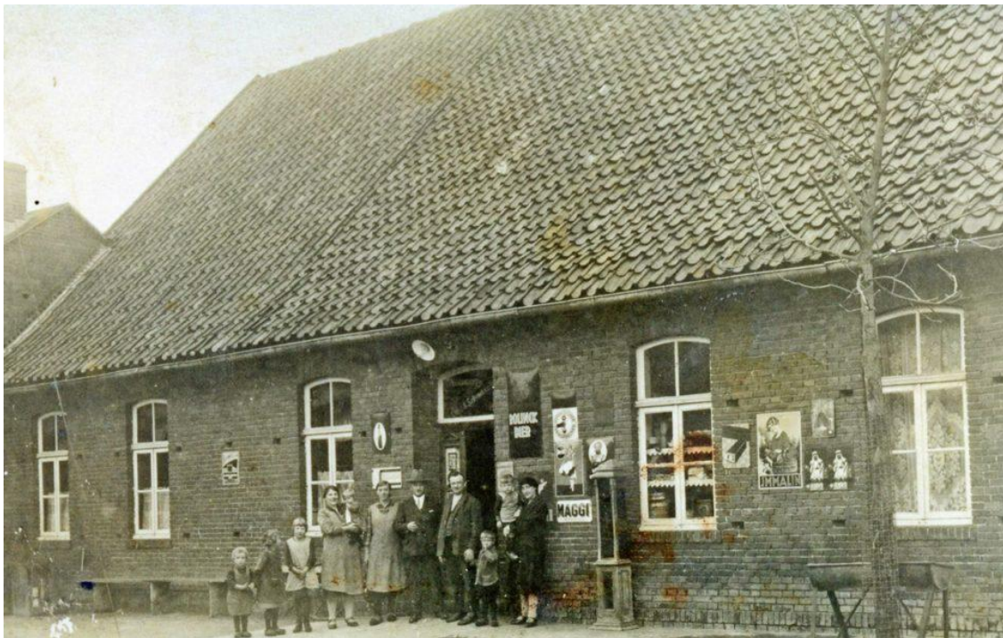
Die alte Gaststätte Hermes in Altenlünne vor dem Umbau, um 1910
